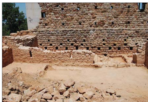
Figura 13. Pati central en primer pla i àmbit B al fons, un cop finalitzada la intervenció de maig-juny de 2018 (E. Píriz).
