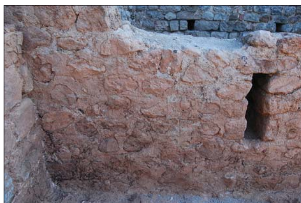
Figura 21. Detall del rejuntat decoratiu realitzat mitjançant morter de calç amb un acabat amb línies incises simulant un carreuat (E. Píriz).
